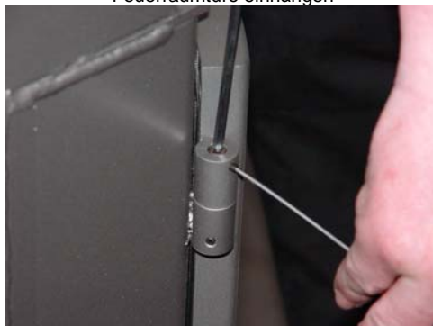
Schritt 7 Mittels Inbusschlüssel die Feder mit der Spezialschraube spannen und mit der Madenschraube kontern.
